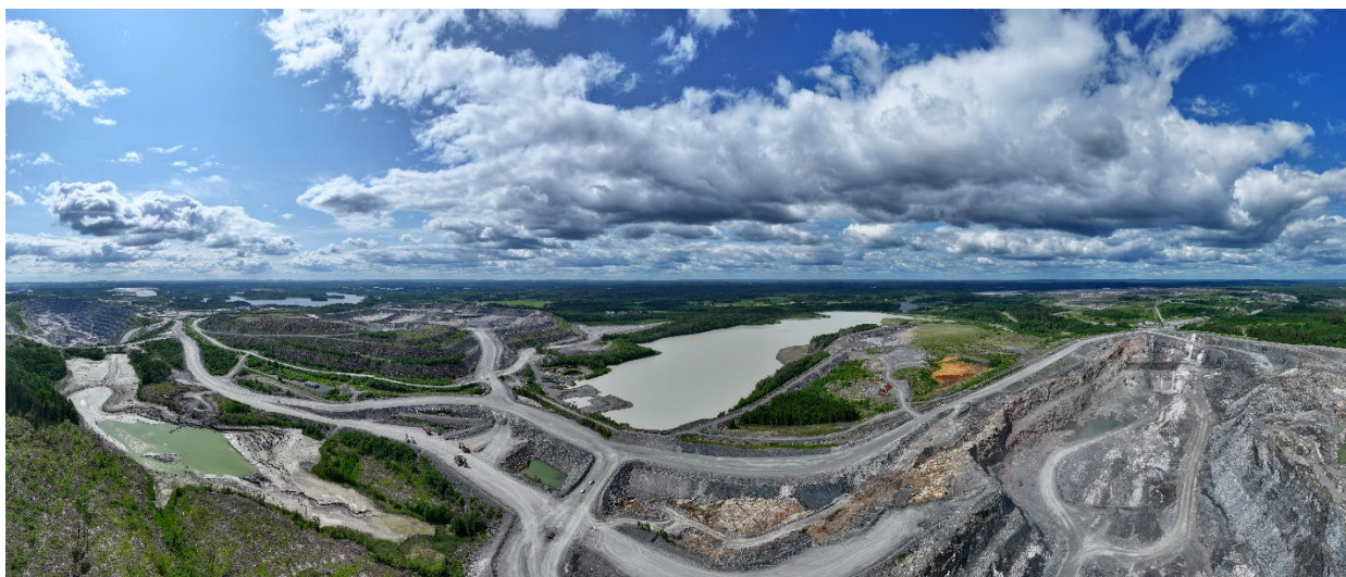
Kuva 2. Jaakonlammen louhos (oikealla), Raasion allas sekä osittain kuivattu Jaakonlammen prosessivesiallas kuvattuna kesäkuussa 2025
