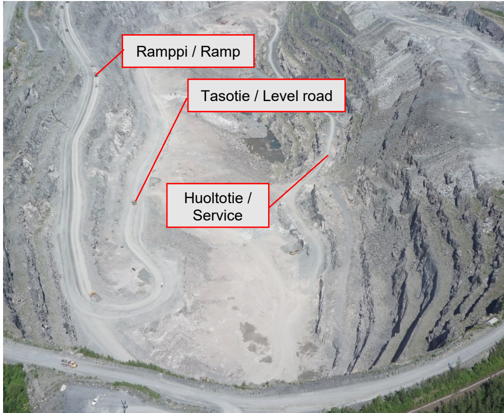
3 Louhoksessa olevat tiettyypit. Types of road in the mine
