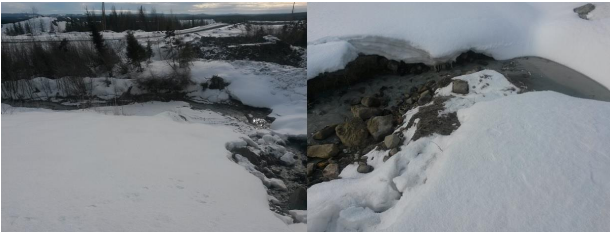
Kuva 8. Padon ylivuoto. Ilmoitettava ylivuodosta välittömästi vuodon suuruudesta riippuen Yaran asiantuntijoille tai edellä mainitun hälytysketjun mukaisesti
