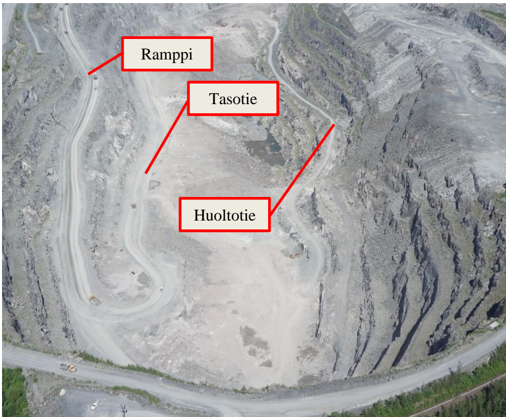
Kuva 2. Louhoksessa olevat tietyypit.
