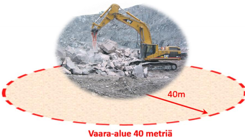
Kuva 4. Käynnissä oleva rikotustyö ja sen vaara-alue.
