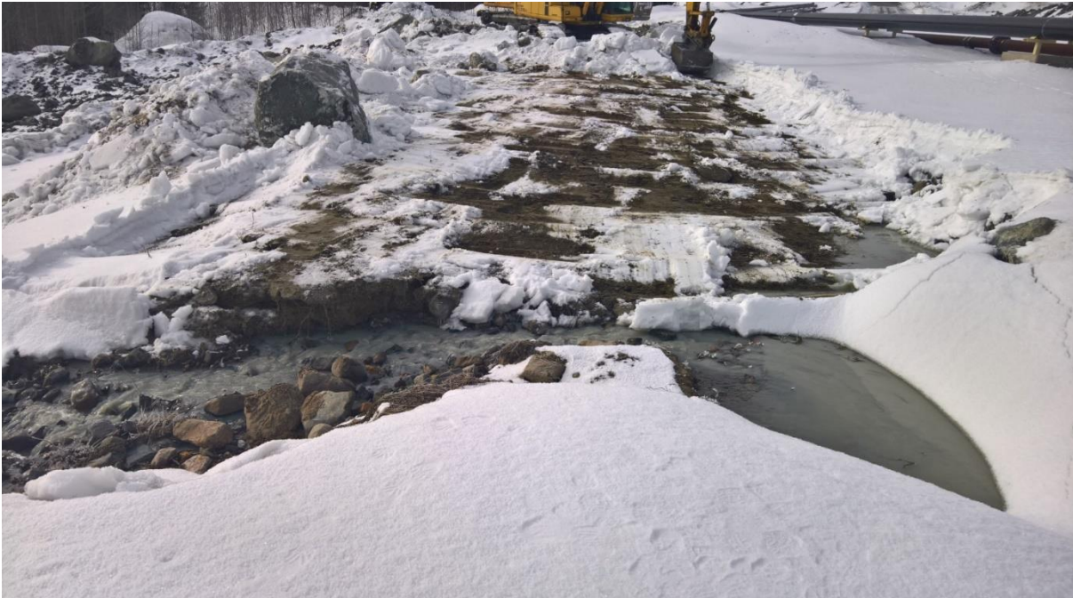
Kuva 7. Padon ylivuoto. Ilmoitettava ylivuodosta välittömästi vuodon suuruudesta riippuen Yaran asiantuntijoille tai edellä mainitun hälytysketjun mukaisesti
