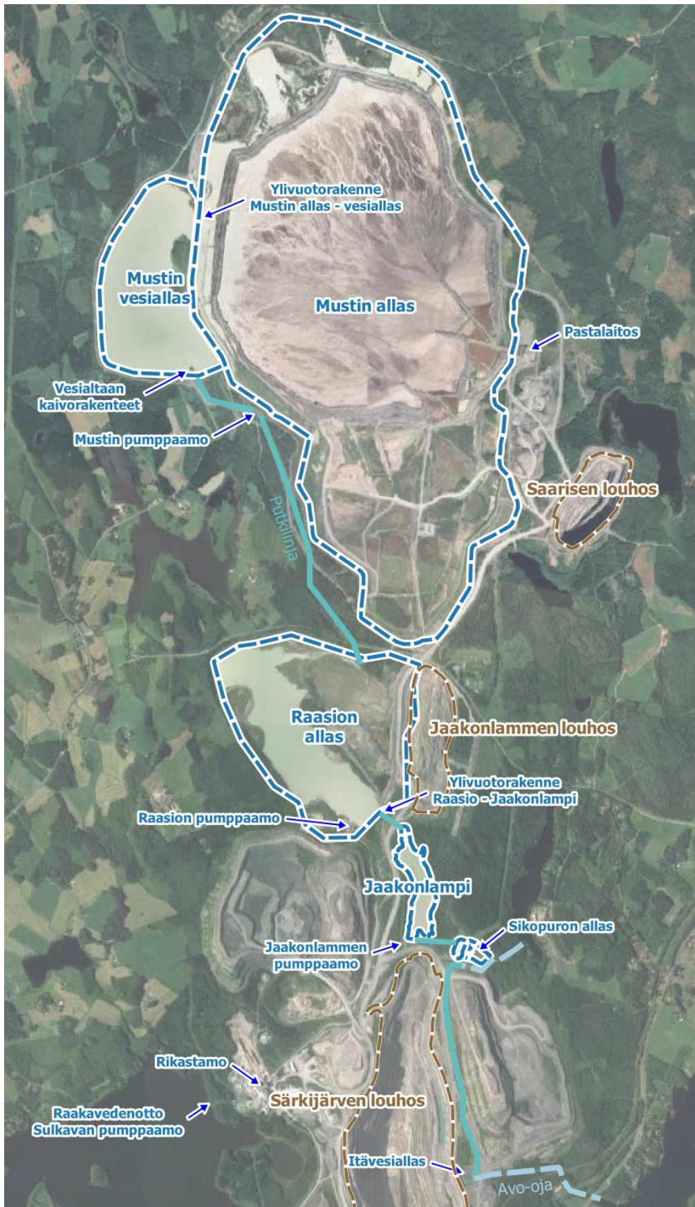
Kuva 6. Kaivoksen pato- ja vesiallasalueet.
